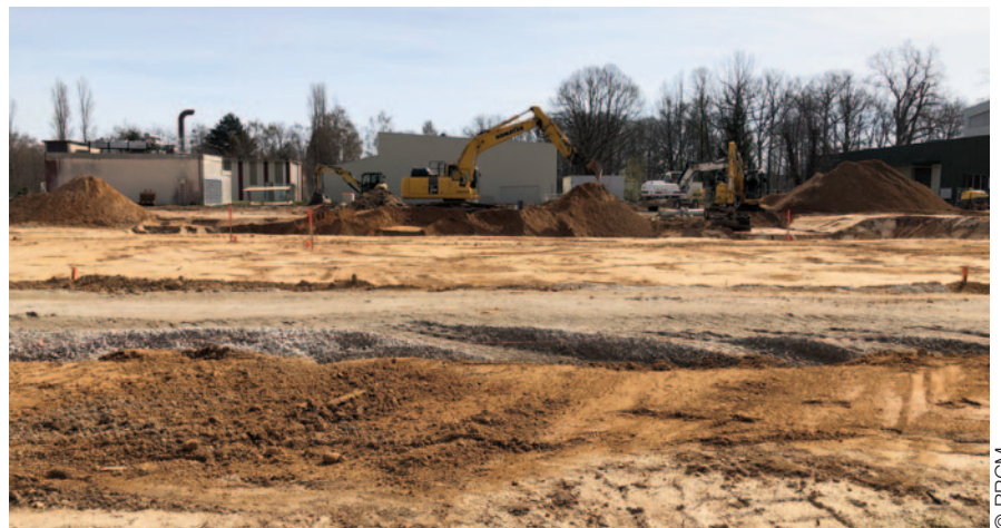
Chantier Batlab au BRGM à Orléans.
